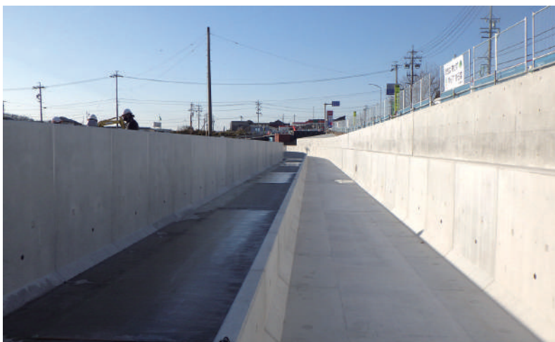
耐震化事業が完了した枝下用水（四郷町地内）
