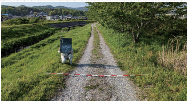
施工前(加納町)
