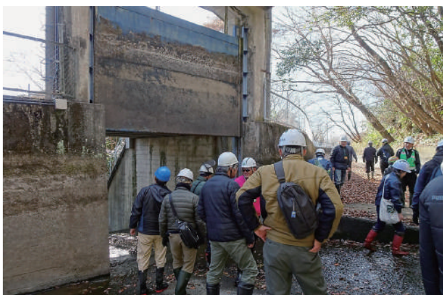
第一放水門（平戸橋町）
