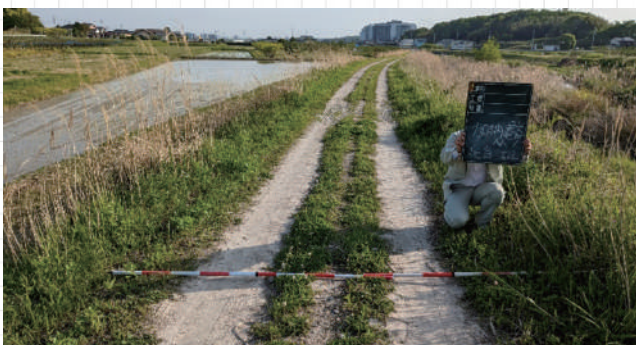
施工前(亀首町)
