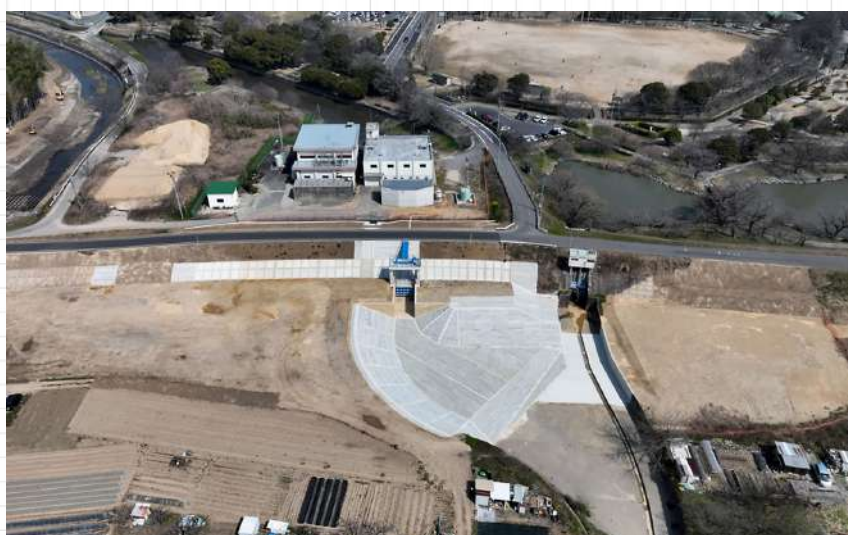
上郷柳川瀬排水機場(岡崎市北野町)
