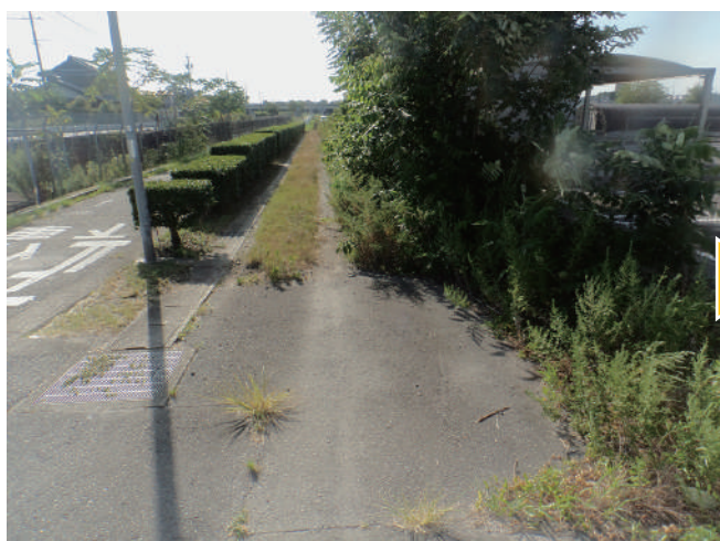
施工前（豊田市鴛鴦町）
