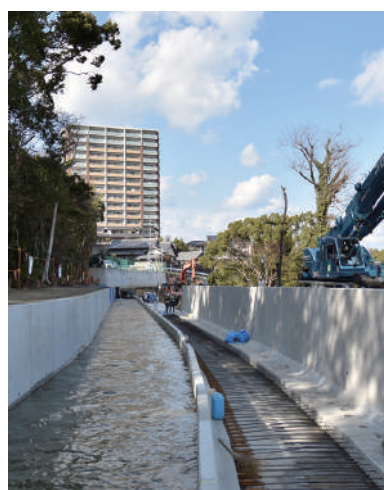
枝下用水幹線水路 施工中（月見町）
