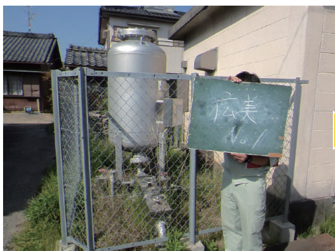
施工前（豊田市広美町地内）
