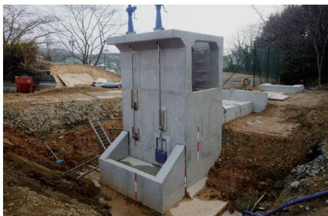
竖樋施工中（豊田市田初町地内）
