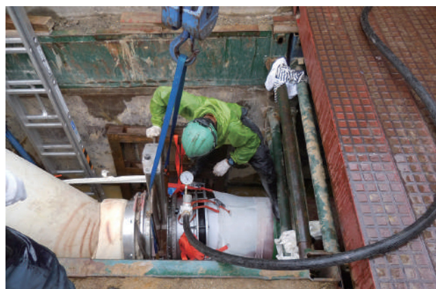
管更生施工中（豊田市堤本町地内）
