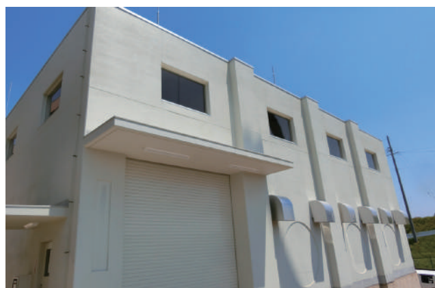
排水機场上屋竣工（畝部東町）
