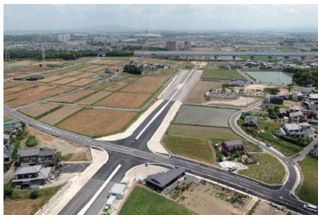
中田地区の畑部と県道市道交差点（南より北を望む）
