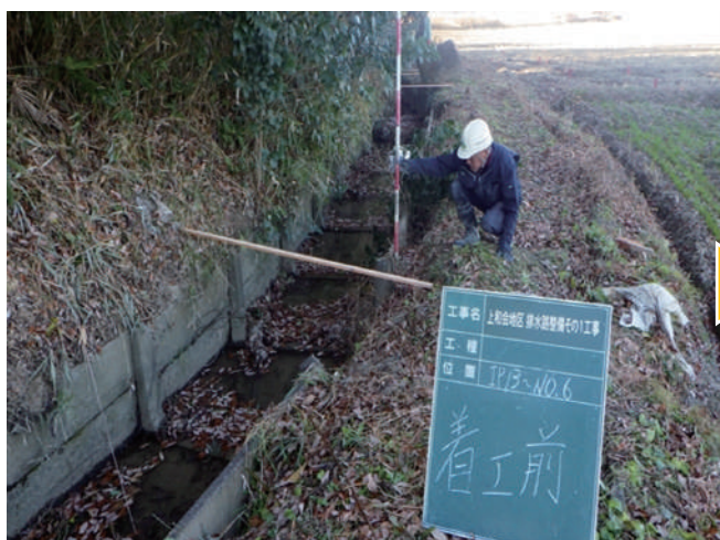
施工前（豊田市上和会町）
