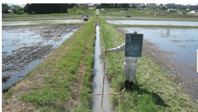
施工前（豊田市川田町地内）
