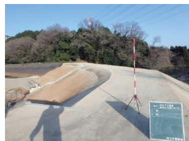
施工後（東保見町）
