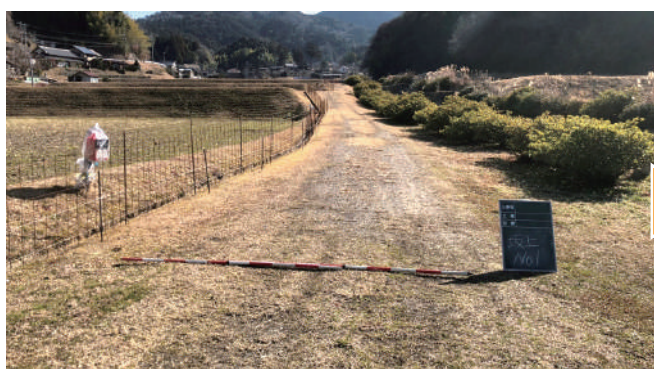
施工前（豊田市坂上町地内）
