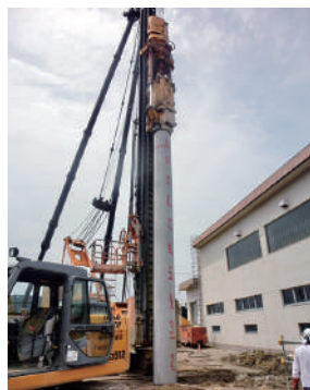
下部工基礎杭施工状況（畝部東町）
