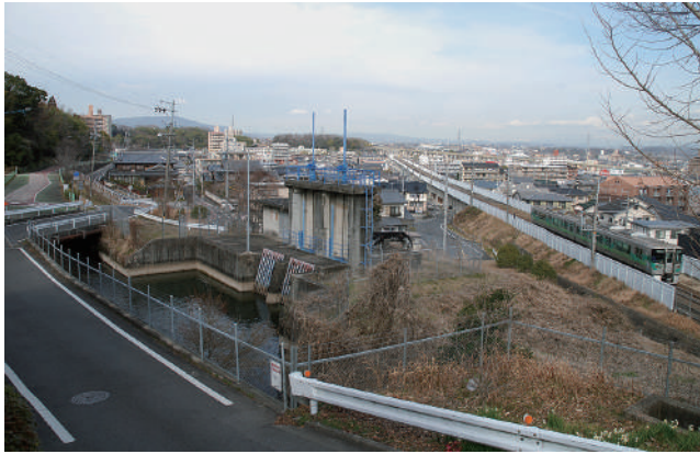
改修前の枝下用水幹線水路と8-2放水門（梅坪町）
