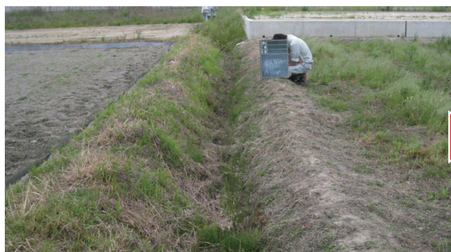
施工前（豊田市畝部西町）
