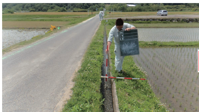
施工前（豊田市保見町地内）
