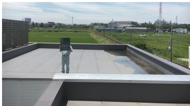
施工前（豊田市司町）
