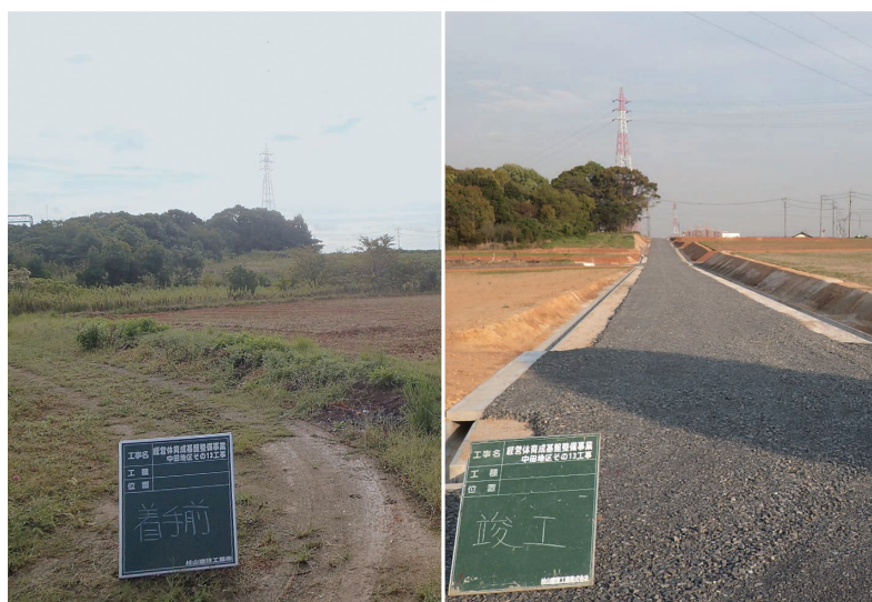
中田地区工事着手前・完了
