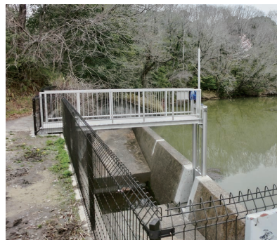
完成した緊急放流施設
